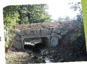
Pont cadre installé sur le Chandonnet
